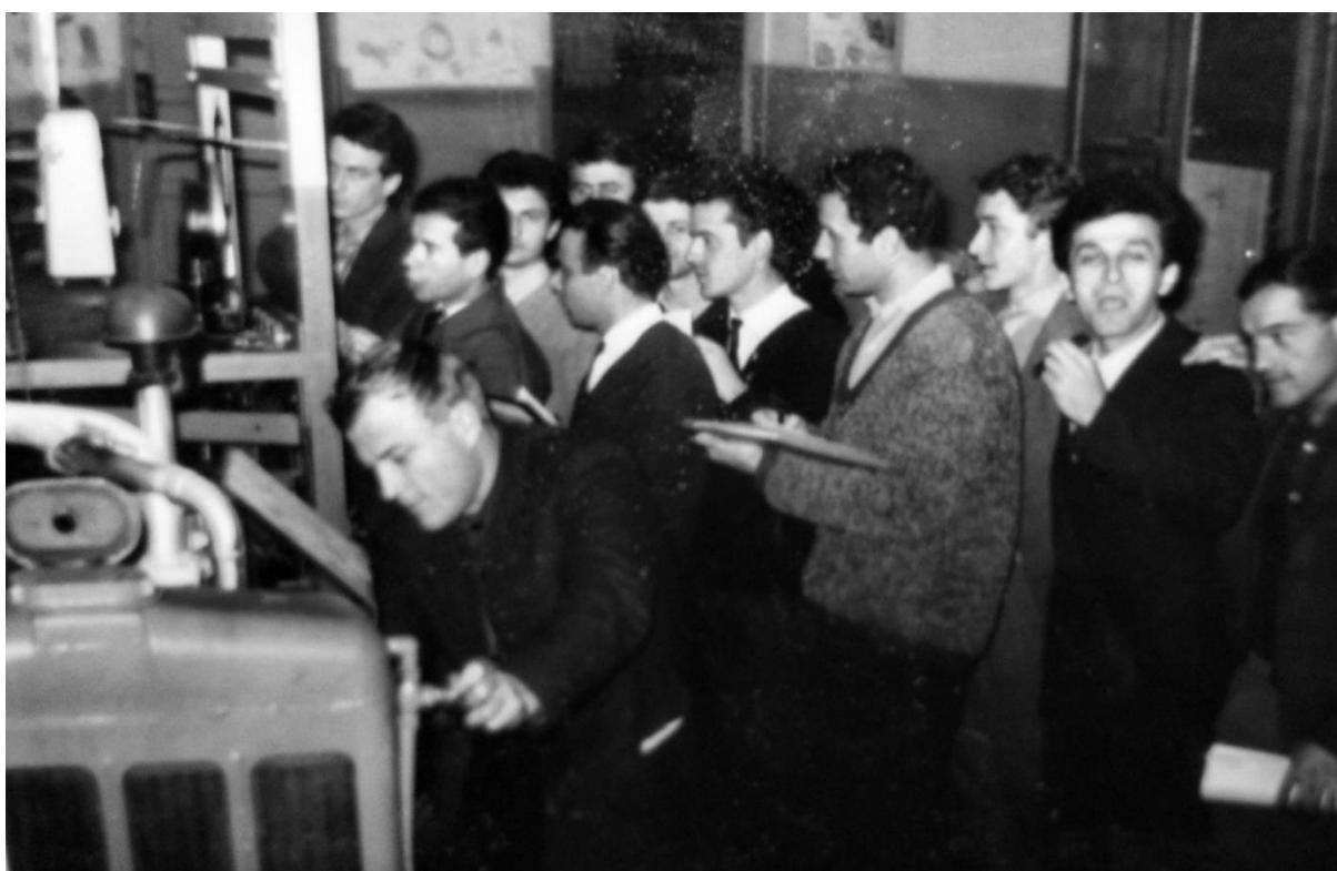
O subgrupă de studenți la Laboratorul de Motoare (1966).
