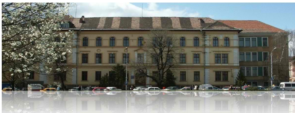
Figura 1.2 Sediul Facultății de Inginerie Mecanică (corp N – anul 2014)
