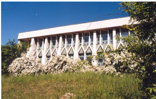
Figura 2.5.1 Sediul catedrei de Rezistența Materialelor și Vibrații
